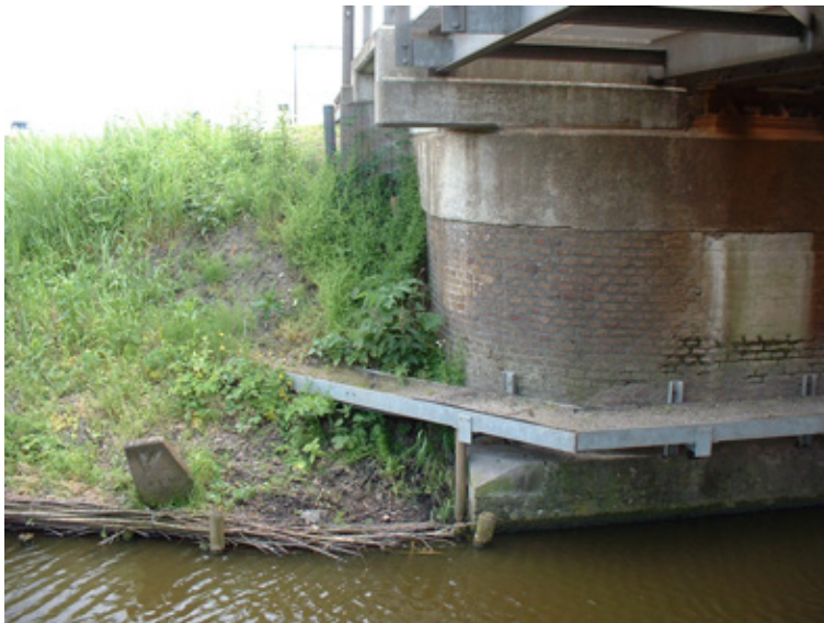
Figuur III 15 Loopstrook onder brug.
