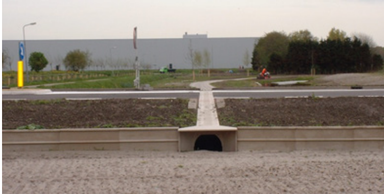
Figuur III 14 Halfopen amfibieëntunnel.
