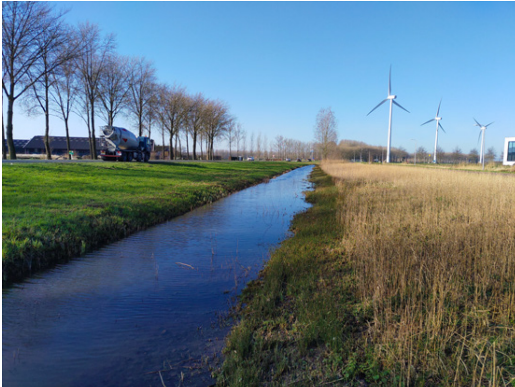
Figuur 3.12 Natuurvriendelijke oever langs de Dieselweg.
