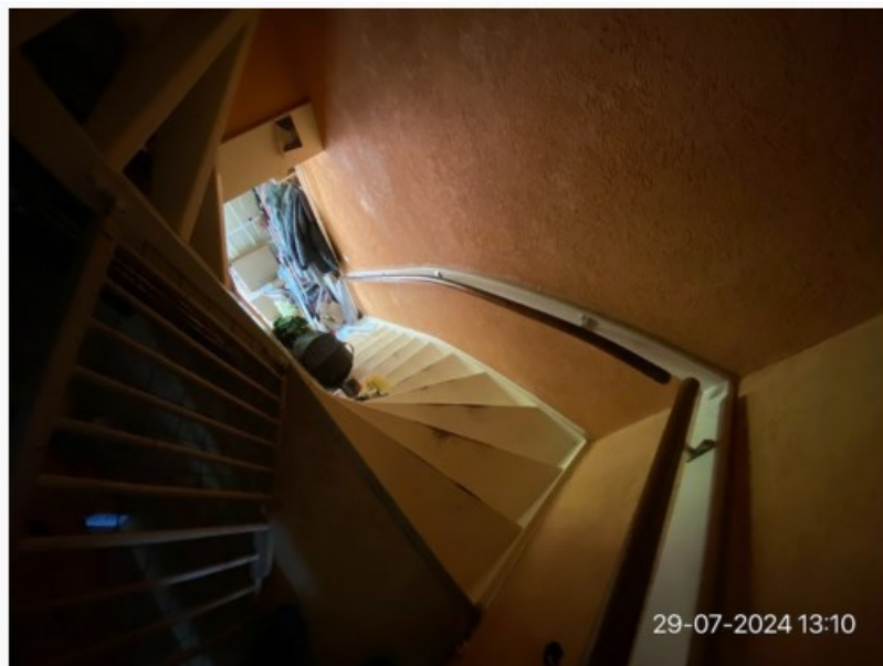
Foto 51; Trap van begane grond naar de eerste verdieping.
