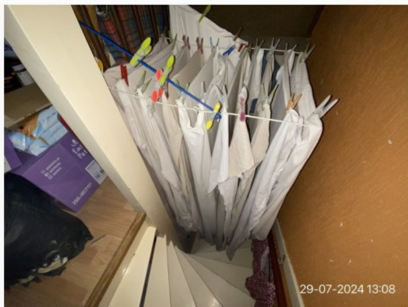
Foto 41; Zolder van de woning en trap nauwelijks te bereiken.
