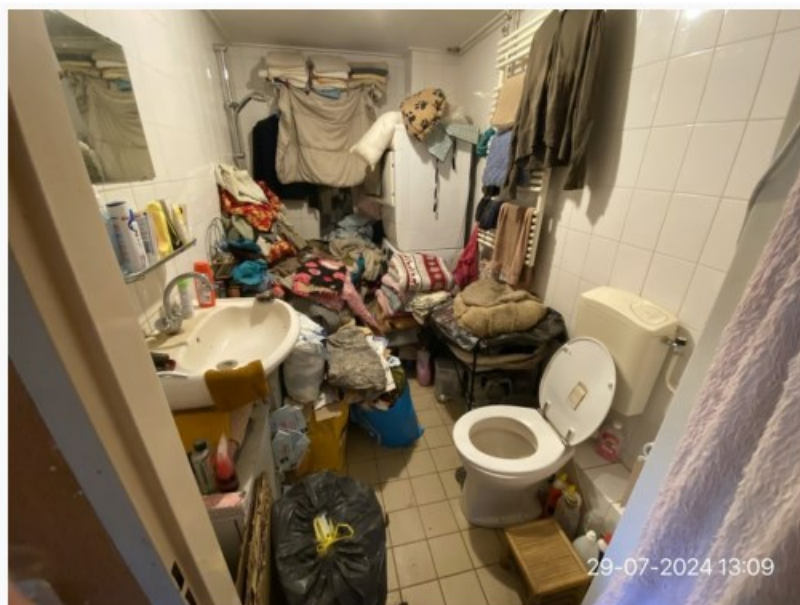
Foto 49; Badkamer eerste verdieping, douche niet te gebruiken door opslag.
