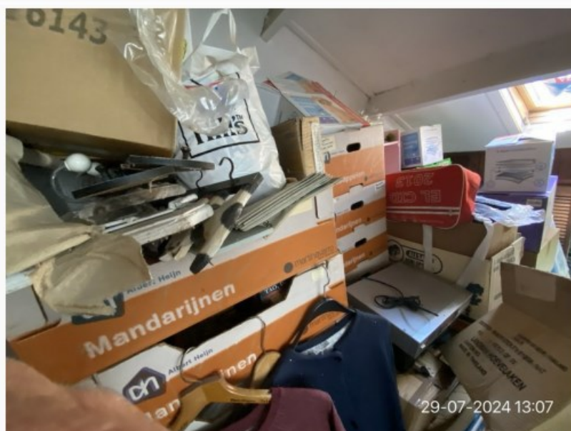
Foto 36; Zolder van de woning met vele brandgevaarlijke opslag.
